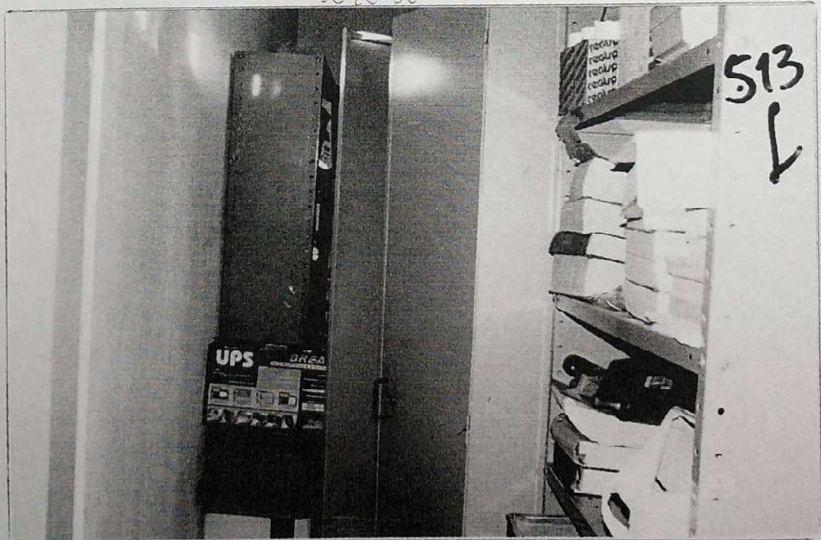
Parte interna do almoxarifado localizada no pav. térreo do edifício no 2 (C).
