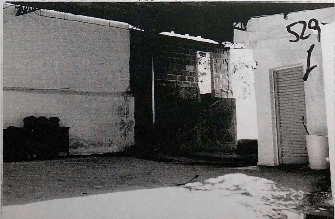
fundo do escritório 1 e parte do depósito.
