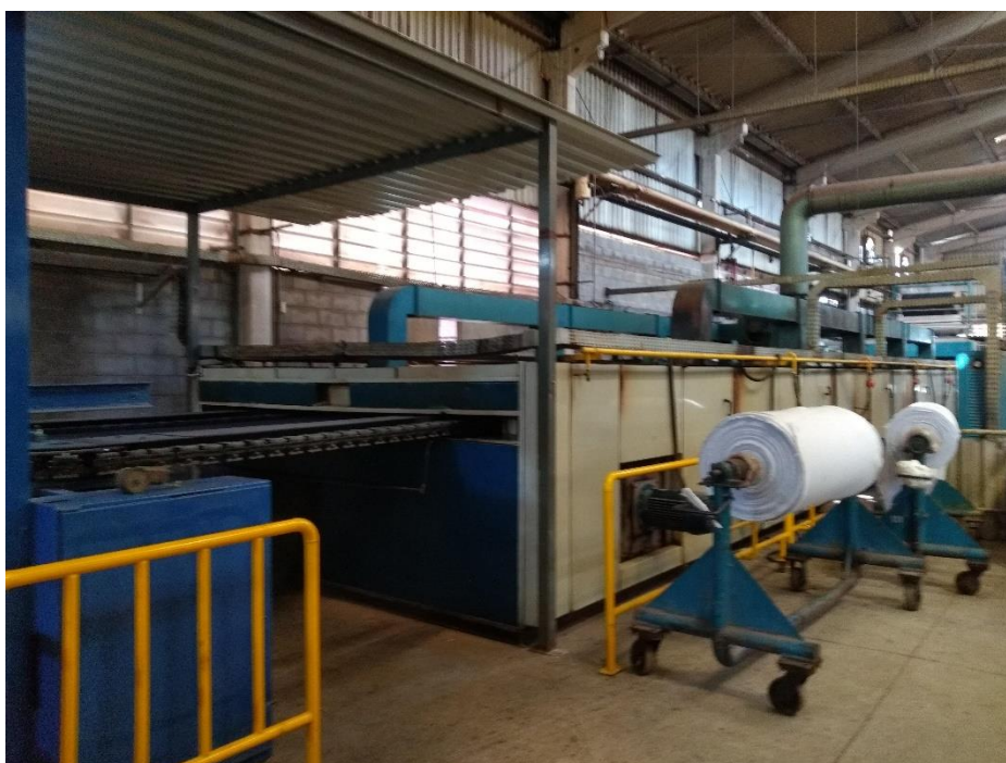
Outra vista do galpão 1
