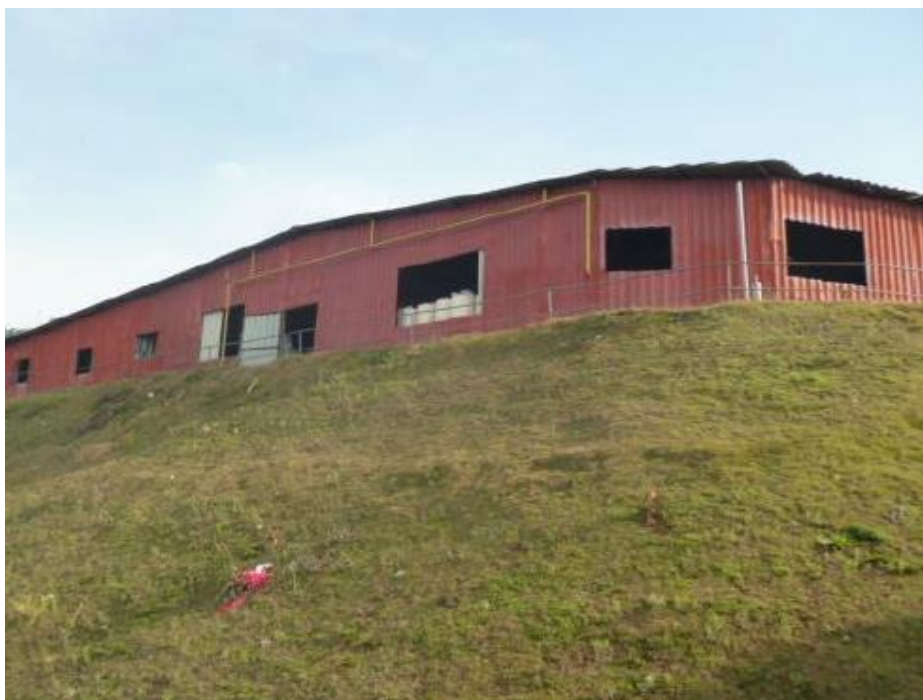
Vista do galpão 2
