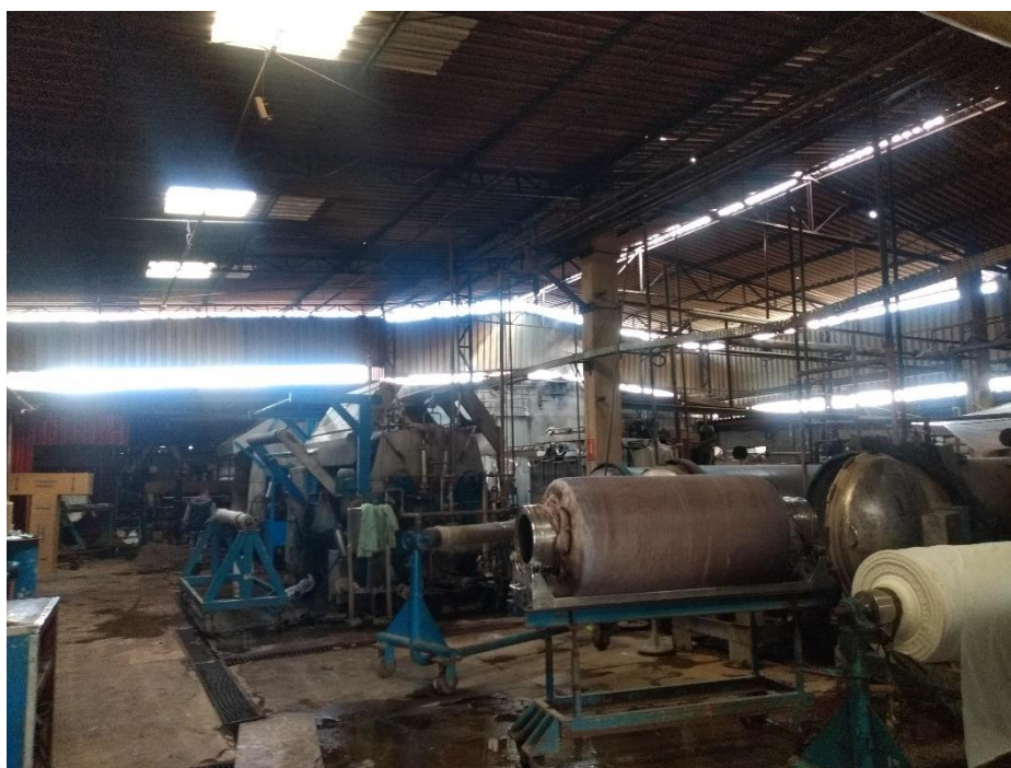
Vista do galpão 4
