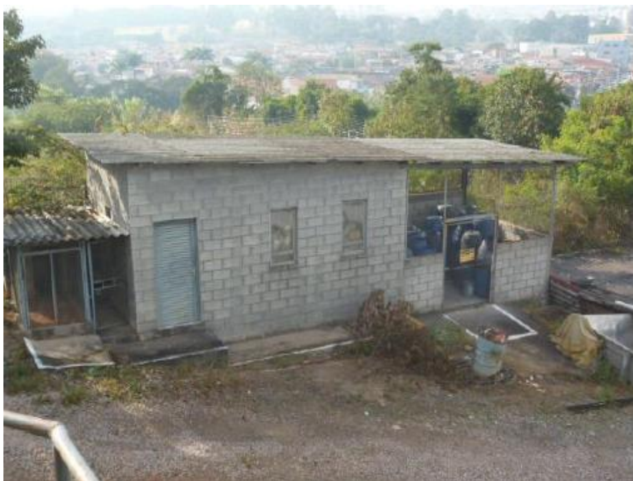
Vista do depósito de inflamáveis
