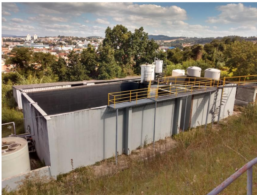
Vista da ETE
