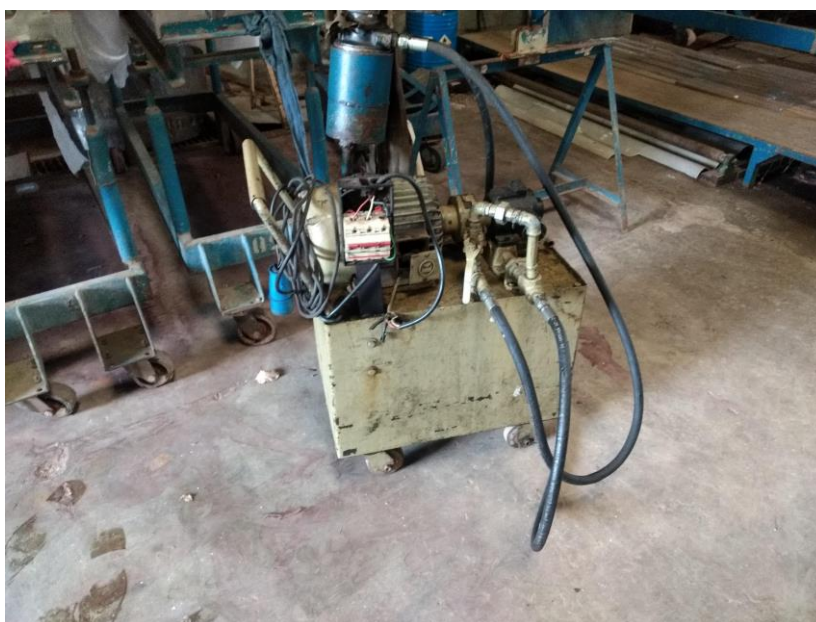
Vista da unidade hidráulica
