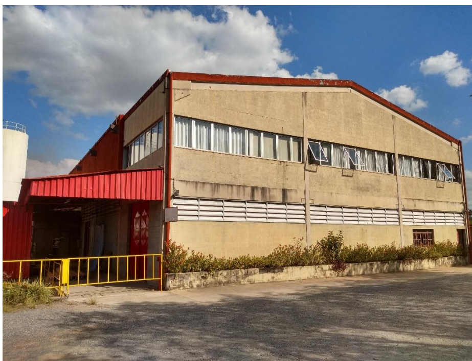
Vista do galpão 1.
