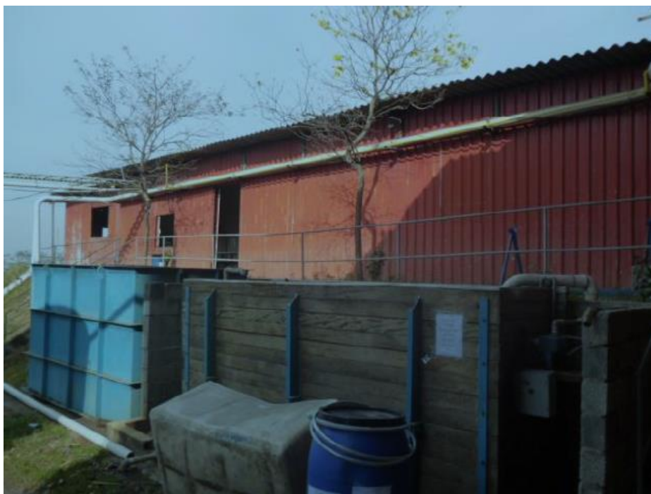
Vista do galpão 3
