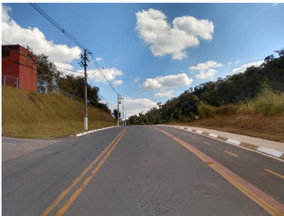
Vista da Estrada Da Mina no trecho em que o imóvel faz frente principal.
