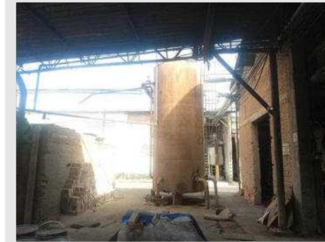
TANQUE CILÍNDRICO VERTICAL RETORNO DE CONDENSADO DIAM 200X400 CM | Item: 175 |
