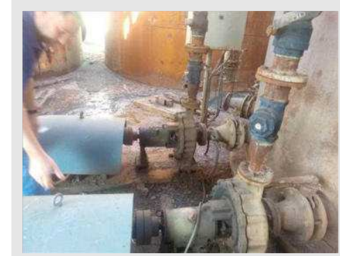
BOMBA CENTRÍFUGA MARCA THEBE MOD TH50315 COM MOTOR DE 15 CV | Item: 3 |
