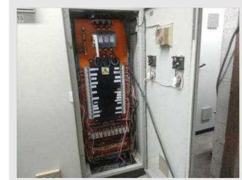
PAINEL ELÉTRICO DIM 70X200X60 CM 220V | Item: 228 |
