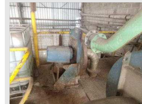
EXAUSTOR CENTRIFUGO MARCA KWCA MOD RT N DIAM 100 CM MOTOR 7.5 CV VASÃO 1170 M³/H | Item: 135 |
