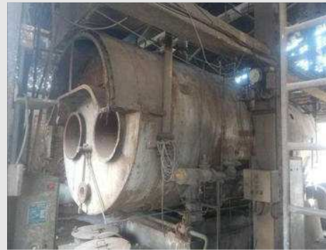
CALDEIRA III A GAS CAP 1200 L X 10.5 KGF/CM 2 MARCA AALBORG MOD AIR4 ANO 1998 COM SISTEMA DE EXAUSTÃO E PAINEL | Item: 172 |
