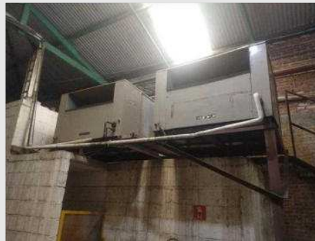
CENTRAL DE AR PARA CLP ELETRICA COM 2 CONDENSADORAS E 2 EVAPORADORAS MARCA. HITACHI MOD RAS1000AC | Item: 234 |
