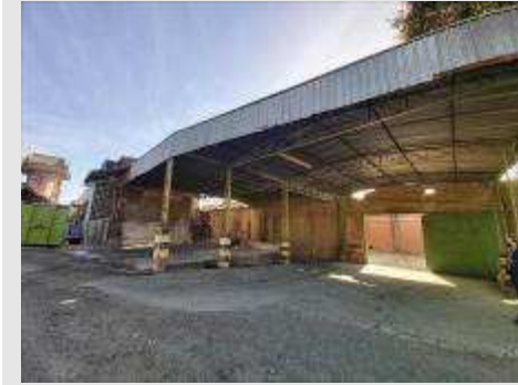
Galpão de Matéria Prima, Depósito e Preparo de Massa - Matrícula 86.291
