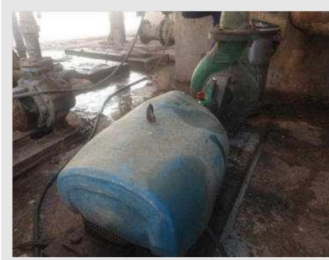
BOMBA CENTRÍFUGA MARCA IMBIL (4POL) COM MOTOR DE 15 CV | Item: 2 |
