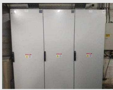
SISTEMA DE AUTOMAÇÃO CCM RETROFIT (MÁQUINA DE PRODUÇÃO DE PAPEL) COM PAINEL CONTROLE CLP MARCA SIEMENS COM 3 PORTAS DIM 240X230X70 CM | Item: 233 |
