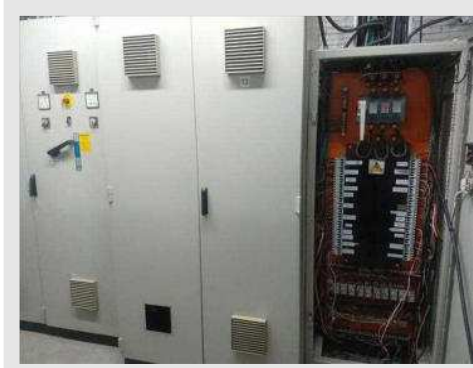
PAINEL ELÉTRICO COM 2 PORTAS DIM 120X220X80 CM 220V | Item: 227 |
