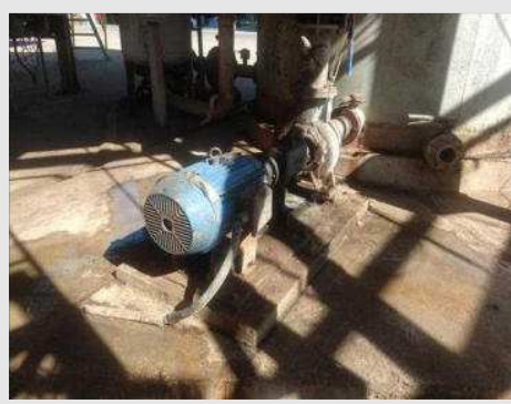
BOMBA CENTRÍFUGA MARCA IMBIL MOD IN 10/150 COM MOTOR DE 20 CV | Item: 33 |
