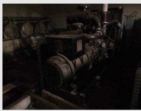
GRUPO GERADOR MARCA STEMAC POT 450 KVA | Item: 241 |
