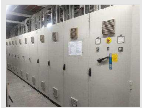
PAINEL ELÉTRICO COM 13 PORTAS DIM 1000X220X60 CM 380V | Item: 226 |
