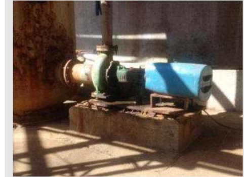
BOMBA CENTRÍFUGA MARCA IMBIL MOD IN 180/180 COM MOTOR DE 7.5 CV | Item: 12 |
