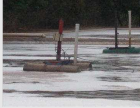
TURBO AERADOR OXIGENADOR MARCA HELIBOMBAS MOD HMO COM MOTOR DE 15CV | Item: 251 |
