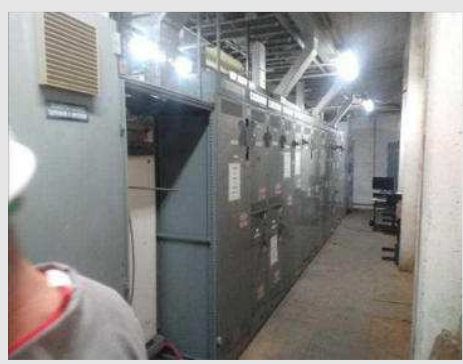
PAINEL ELÉTRICO COM 19 PORTAS DIM 1100X223X70 CM 380V | Item: 232 |
