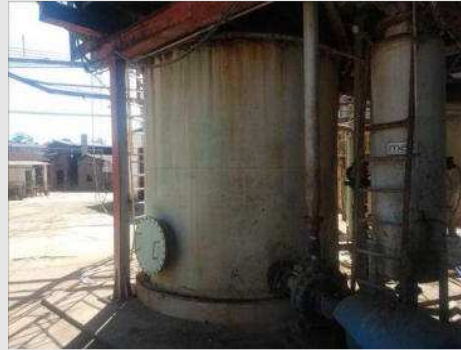
TANQUE CILÍNDRICO VERTICAL EM AÇO CARBONO DIAM 250X300 CM (ÁGUA CLARIFICADA) | Item: 10 |
