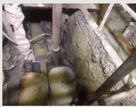
DEPURADOR COM MOTOR DE 25 CV E BOMBA CENTRÍFUGA MARCA IMBIL MOD BMI6X4X10 COM MOTOR DE 30 CV | Item: 123 |
