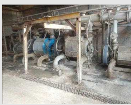
BOMBA DE VÁCUO MARCA NASCH MOD CL 4002 COM MOTOR DE 250 CV | Item: 117 |
