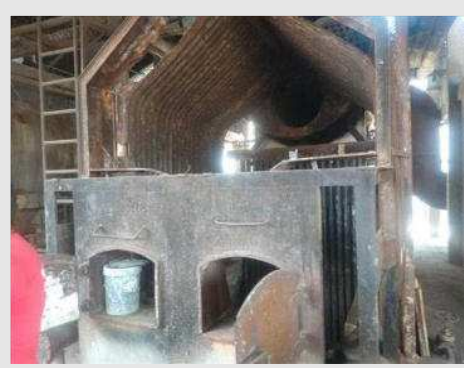
CALDEIRA II A LENHA CAP 7000KGF/H MARCA ATA MOD ATA29LP ANO 1995 COM SISTEMA DE EXAUSTÃO E PAINEL | Item: 171 |
