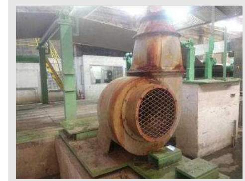
EXAUSTOR CENTRIFUGO MARCA AFC MOD BF586SWS DIAM 100 CM MOTOR 3 CV | Item: 138 |
