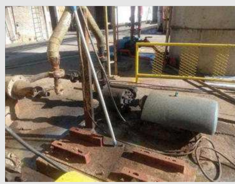
BOMBA CENTRÍFUGA MARCA KSB MOD WL 40/5 COM MOTOR DE 25 CV | Item: 62 |
