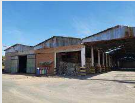
Galpão de Matéria Prima, Depósito e Preparo de Massa - Matrícula 86.291
