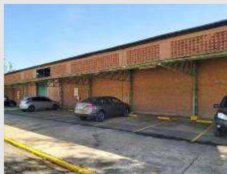
3 S Barracão / Depósito - Matrícula 46.600
