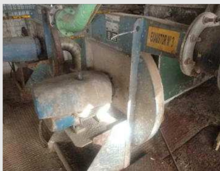
EXAUSTOR CENTRIFUGO MARCA KWCA MOD RT N DIAM 100 CM MOTOR 7.5 CV VASÃO 1170 M³/H | Item: 134 |
