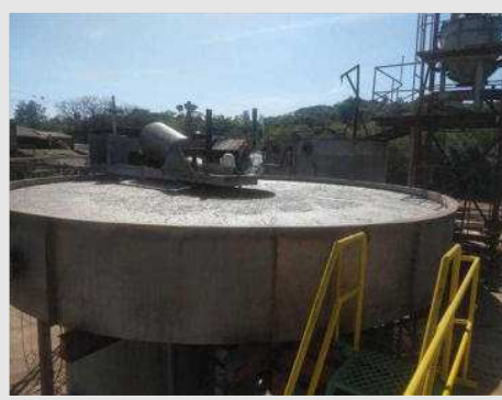
FLOTADOR E FLOCULADOR EM AÇO INOX MARCA MERI (VOITH) MOD HDS180 CAP 230-280M 3 /H DIAM 8120X2220 MM | Item: 93 |
