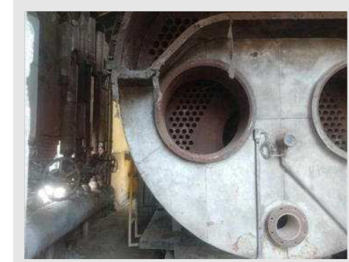
CALDEIRA III A GAS CAP 1200 L X 10.5 KGF/CM 2 MARCA AALBORG MOD AIR4 ANO 1998 COM SISTEMA DE EXAUSTÃO E PAINEL | Item: 172 |
