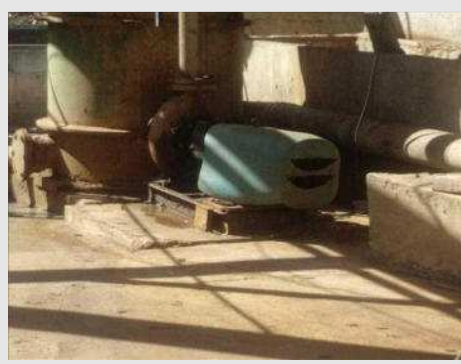
BOMBA CENTRÍFUGA MARCA IMBIL MOD IN 180/180 COM MOTOR DE 7.5 CV | Item: 13 |
