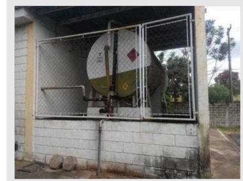
TANQUE PARA COMBUSTÍVEL HORIZONTAL EM AÇO CARBONO CAP 10 M³ | Item: 243 |
