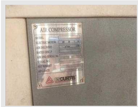
COMPRESSOR DE AR MARCA FS CURTIS MOD SEM 50-8 CAP 63 M³/MIN | Item: 210 |
