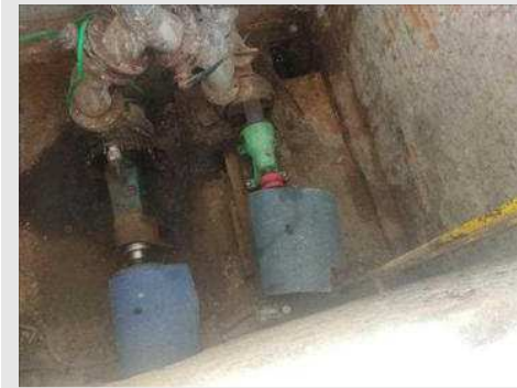
BOMBA CENTRÍFUGA MARCA IMBIL MOD 50/200 COM MOTOR DE 10 CV | Item: 4 |
