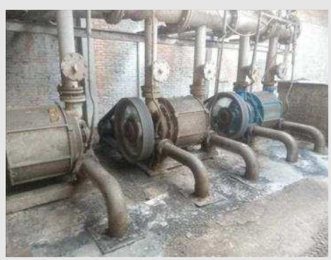
BOMBA DE VÁCUO MARCA NASCH COM MOTOR DE 100 CV | Item: 111 |
