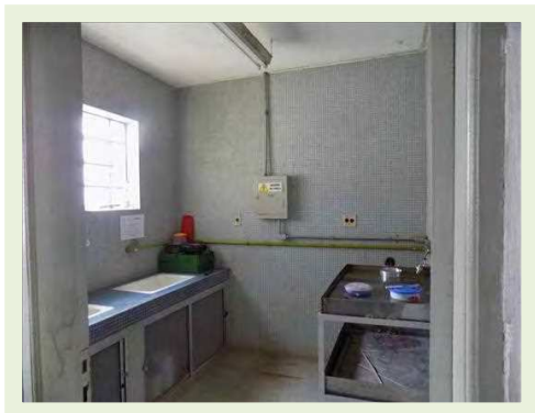
Administrativo/Refeitório/Vestiário - Vista interna - Cozinha
