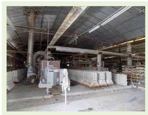
Galpão industrial - Vista interna - Salão
