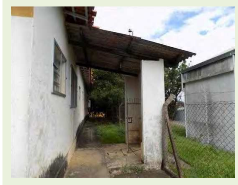
Administrativo/Refeitório/Vestiário - Vista interna - Cobertura
