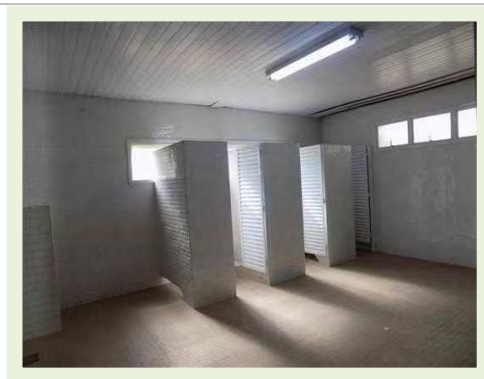
Galpão industrial - Vista interna - Sanitário masculino
