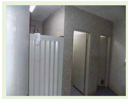
Administrativo/Refeitório/Vestiário - Vista interna - Sanitário masculino
