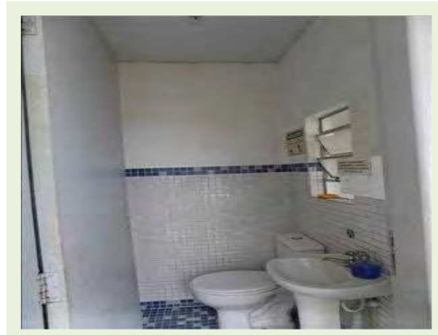
Portaria - Vista interna - Sanitário
