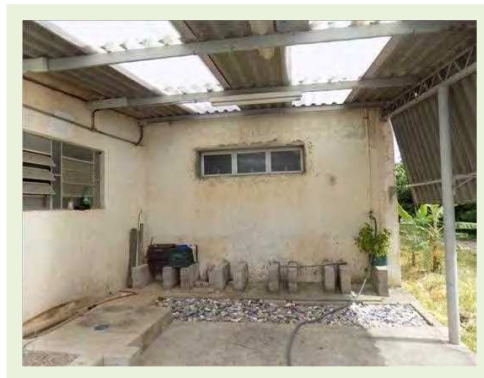
Galpão industrial - Vista interna - Cobertura
