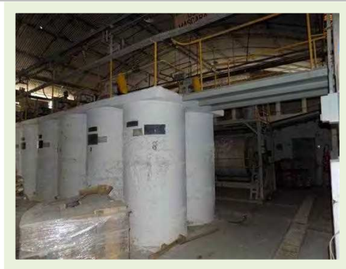
Galpão industrial - Vista interna - Salão
