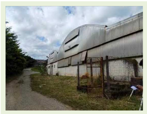
Galpão industrial - fundos
