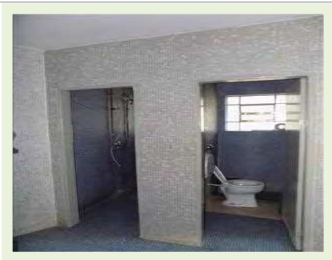
Administrativo/Refeitório/Vestiário - Vista interna - Sanitário feminino
