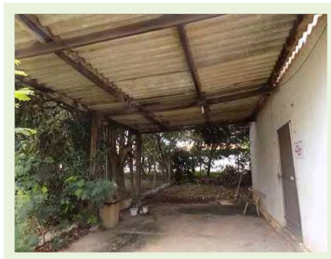
Administrativo/Refeitório/Vestiário - Vista interna - Cobertura
