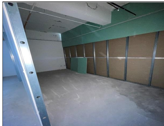
Espaço com divisória em Drywall
