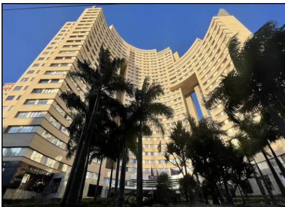
Fachada do Flat
