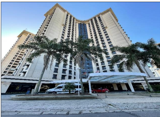
Fachada do Flat
