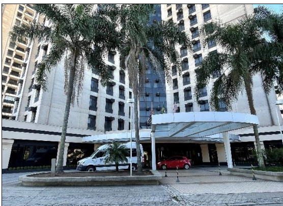
Fachada do Flat
