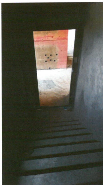
Figura 8 – Escada de acesso aos andares superiores.
