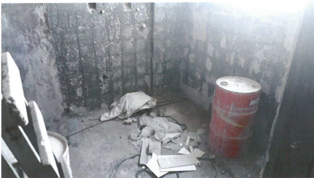
Figura 14 – imagem interna do apartamento, áreas de serviço.
