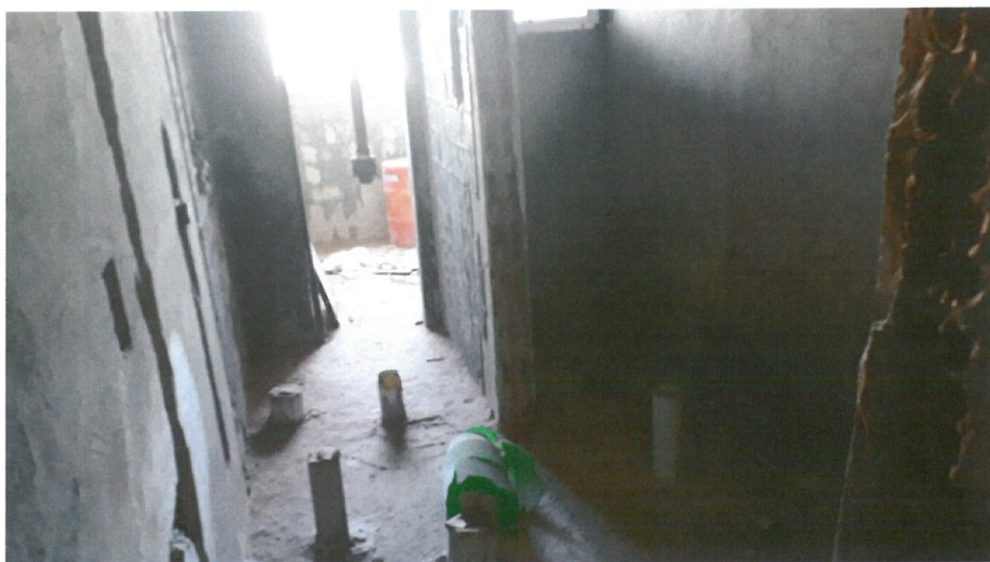
Figura 18 – imagem interna do apartamento, banheiro.
