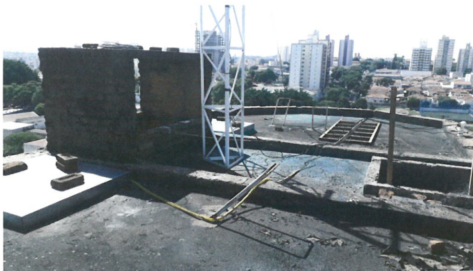
Figura 9 – Terraço do Edifício.
