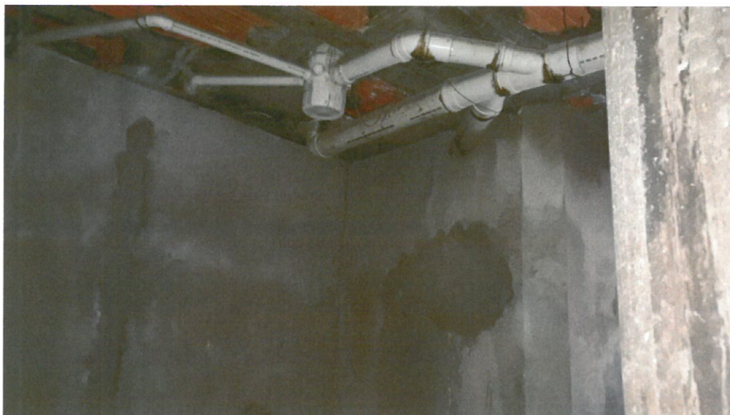
Figura 19 – imagem interna do apartamento, banheiro.
