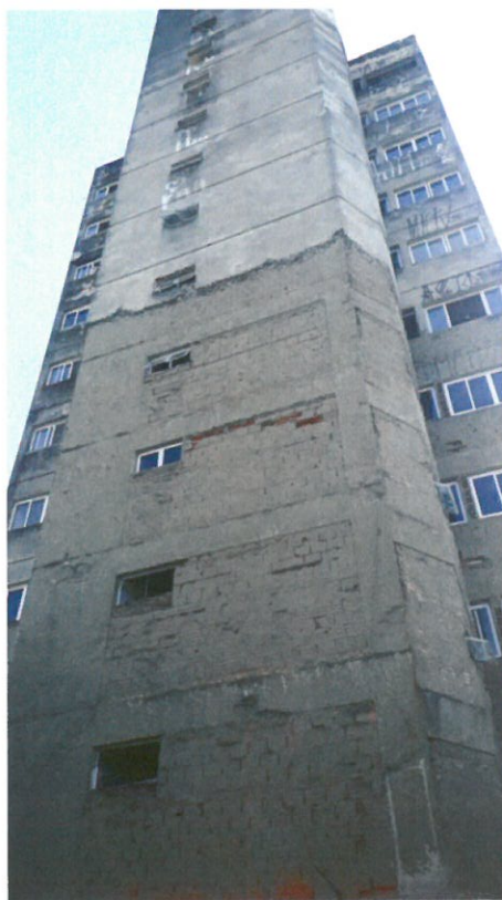
Figura 3 – Fachada posterior do Edifício.
