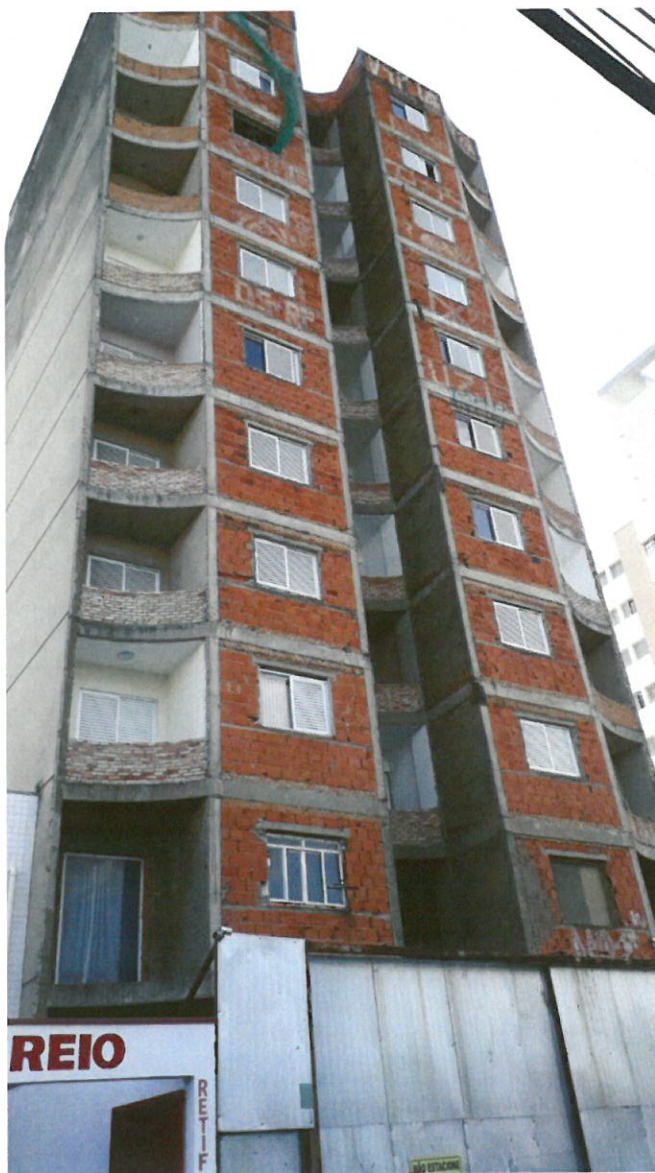
Figura 2 – Fachada do Edifício.
