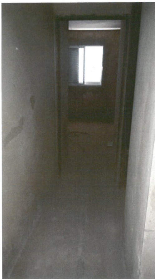
Figura 15 – imagem interna do apartamento, corredor de acesso aos quartos.
