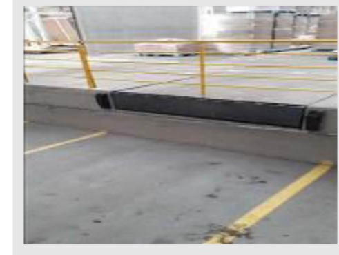
DOCA NIVELADORA HIDRÁULICA MARCA KOPRON MOD. DOCKLEVELLER NA4541 DIM. 2,0X2,20 M | Item: 31 |
