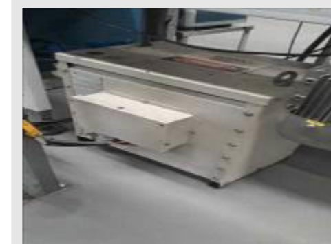
AUTO TRANSFORMADOR A SECO MARCA KIMARKI TIPO TKS POT. 30 KVA 380/220V | Item: 71 |
