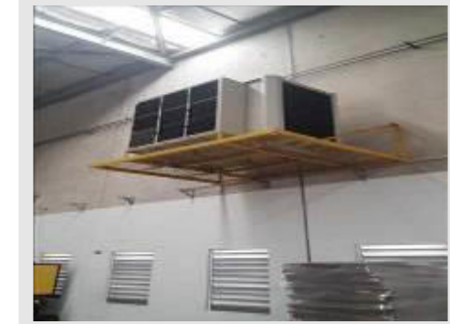
CLIMATIZADOR EVAPORATIVO MARCA ECOBRISA MOD. EBV90 VAZÃO 8500 M3/H | Item: 123 |
