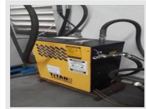
SECADOR DE AR COMPRIMIDO MARCA TITAN C/ PRE E POS FILTROS INTEGRADOS | Item: 125 |
