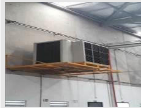
CLIMATIZADOR EVAPORATIVO MARCA ECOBRISA MOD. EBV90 VAZÃO 8500 M3/H | Item: 122 |
