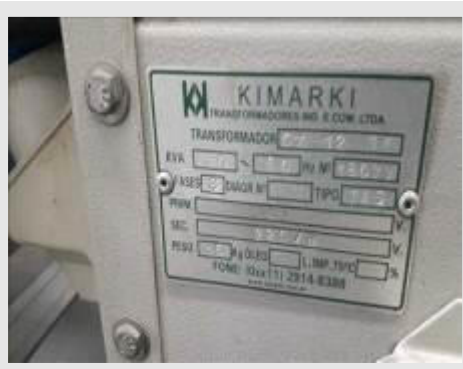
AUTO TRANSFORMADOR A SECO MARCA KIMARKI TIPO TKS POT. 30 KVA 380/220V | Item: 71 |
