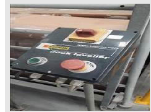
DOCA NIVELADORA HIDRÁULICA MARCA KOPRON MOD. DOCKLEVELLER NA4541 DIM. 2,0X2,20 M | Item: 163 |
