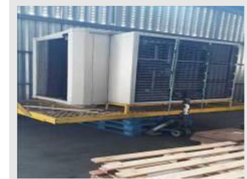
CLIMATIZADOR EVAPORATIVO MARCA ECOBRISA MOD. EBV90 VAZÃO 8500 M3/H | Item: 219 |
